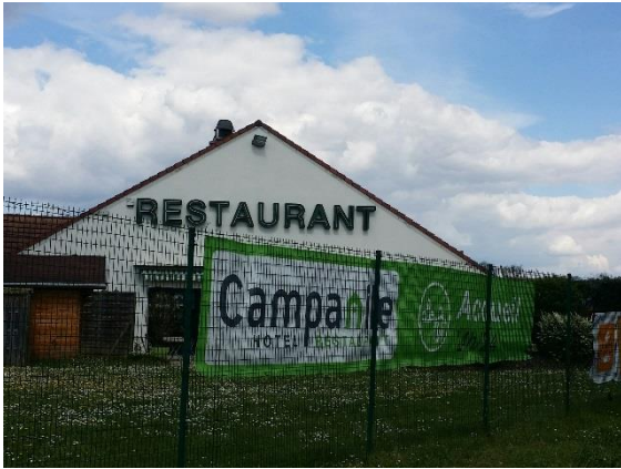
Enseigne en façade en dépassement niveau égout du toit
