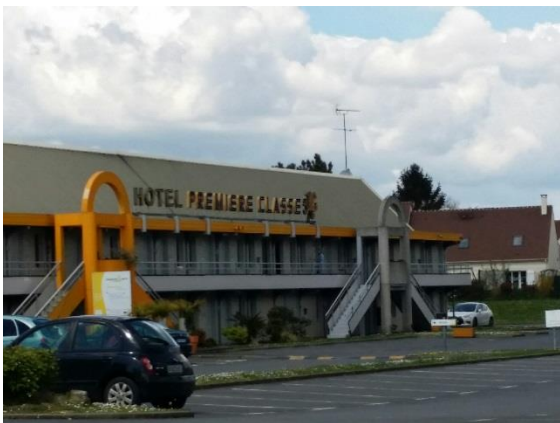
Enseigne installée en toiture à deux pans
